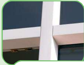
gecontramalde lasverbinding met "pen- en gatlook"
