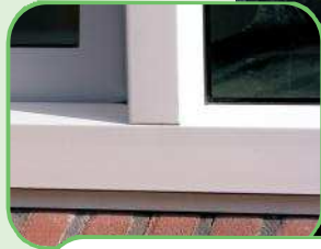
gecontramalde lasverbinding met "pen- en gatlook"
